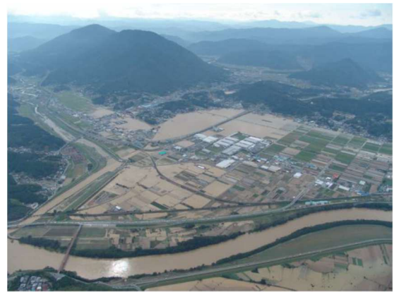
H16 台風第 16 号 肱川氾濫（大洲市）
