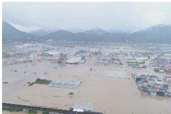
H30 西日本豪雨 肱川氾濫（大洲市）
