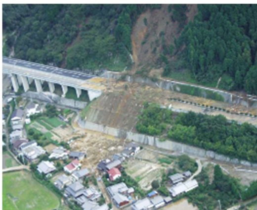
H16 台風第21号 がけ崩れ（新居浜市）
