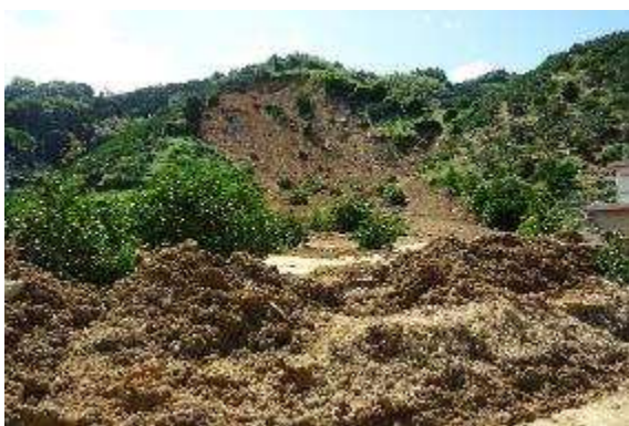
H30 西日本豪雨 土砂崩れ（宇和島市）
