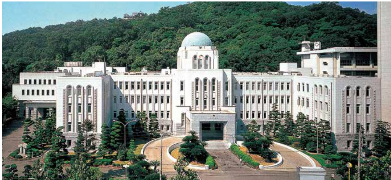
愛媛県庁本館（昭和4年（1929年）2月竣工）
