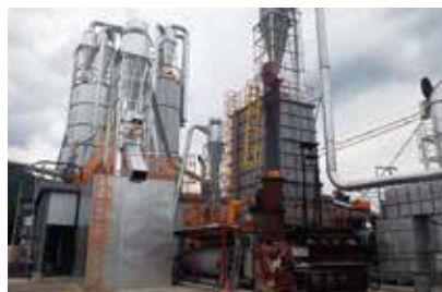
木質バイオマス発電所
