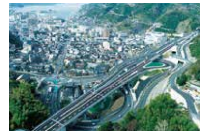
大洲・八幡浜自動車道
