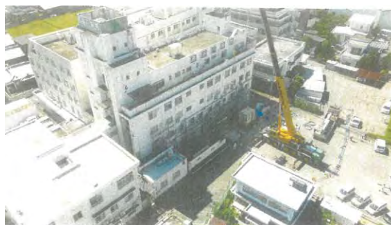
＜医療機関の耐震化工事＞
