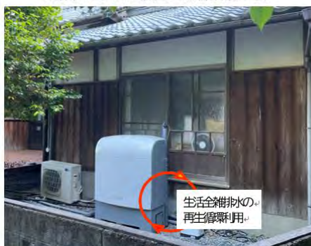
既存住宅の外に設置（配管接続工事）
