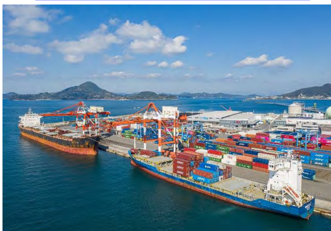
【松山港】2隻同時接岸による離隔不足の状況
