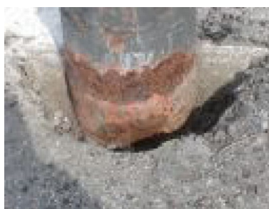
アスファルトを掘削
