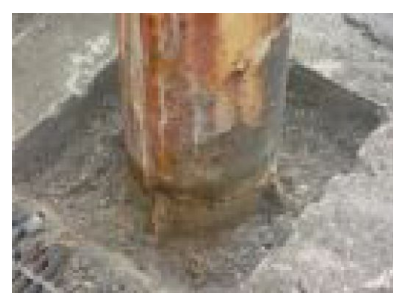
コンクリートを掘削
