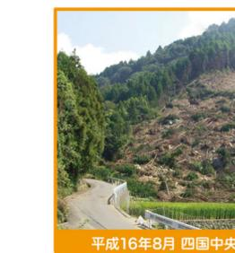
比較的ゆるやかな勾配(かたむき)の斜面が地下水などの影響により、ゆっくりと斜面下方へ移動します。広範囲で起こることが多く、大きな被害を及ぼす可能性が高いです。
