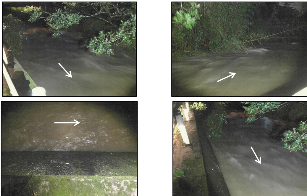
図 3 令和3年（2021年）7月16日～19日（梅雨前線豪雨）被災写真（赤木川）
