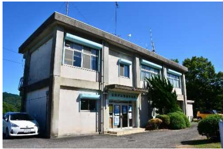
ダム管理事務所
