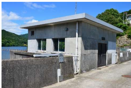
取水ゲート操作室
