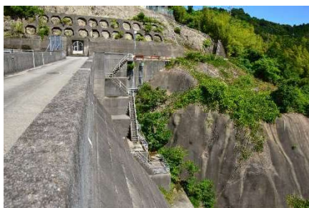
管理用階段通路
