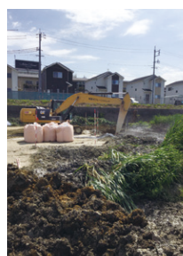
沼地の地盤改良固化
