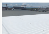
倉庫屋根 (群馬県)
