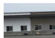
工場屋根と壁面 (愛媛県)
