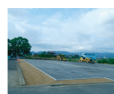
駐車場の造成工事
