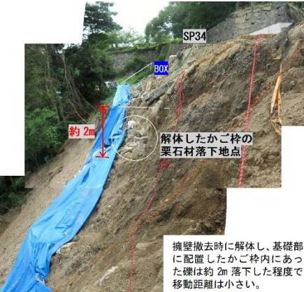
図 3.3-6 緊急車両用道路擁壁の撤去後の基礎と滑落崖の関係
