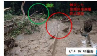
写真1-3 急傾斜地崩壊防止施設の被災状況
