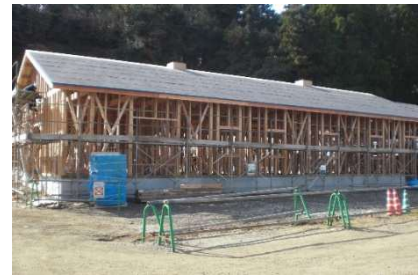
（建築中の厩舎）
