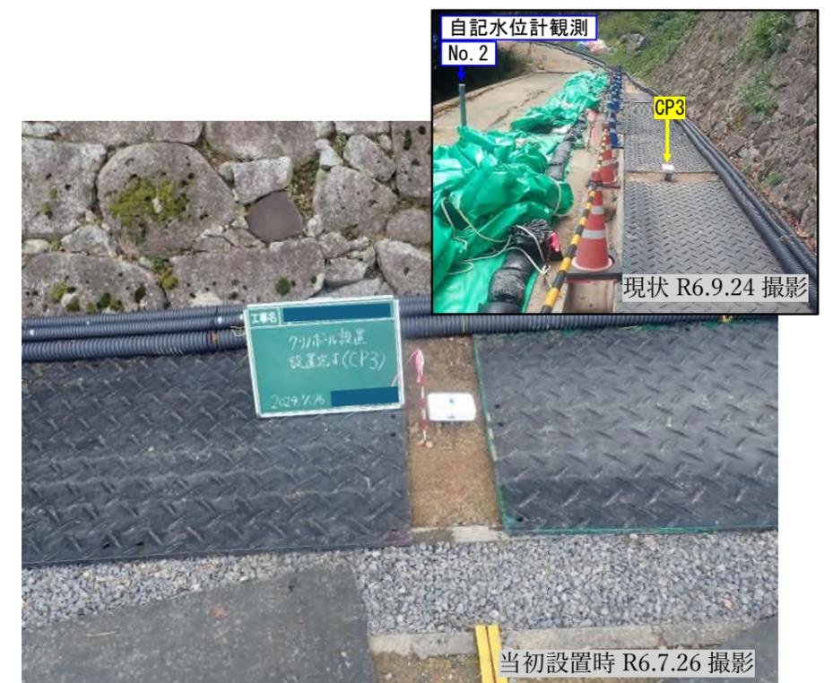
写真5 クリノポール CP3 設置状況
