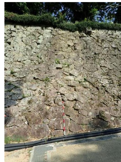
写真-18 天神櫓南石垣に認められる流水跡 流水跡の直下には側溝水路が設置されている。
