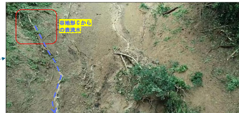
図 2-14 上流部下部最上部 (2 つの谷の合流区間) の谷地形 C から表流水状況
