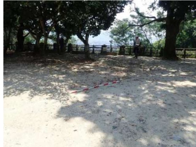
写真-5 良門南側の広場に認められる地表の流水跡 表流水は南東方向へ流れ、良門南石垣を流下する。
