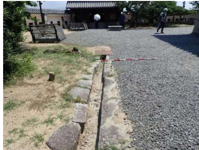
写真-2 天神櫓前広場の側溝水路および暗渠水路 天神櫓前広場を横断する側溝水路および暗渠水路が認められる。 表流水は東側（天神櫓側）へ集められる。
