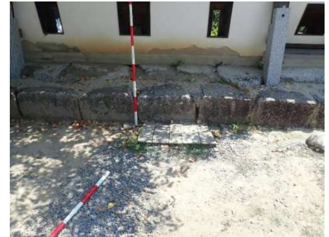
写真-3 天神櫓南堀の内側にある集水樹 天神櫓南堀内側に集水樹があり、一帯の表流水が集められる構造となっている。天神櫓南堀を横断する暗渠が設置されている。
