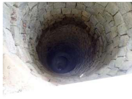
写真 4-2 井戸内部の状況 石積みで造られた掘井戸、途中で屈曲している 水面がわずかに確認される
