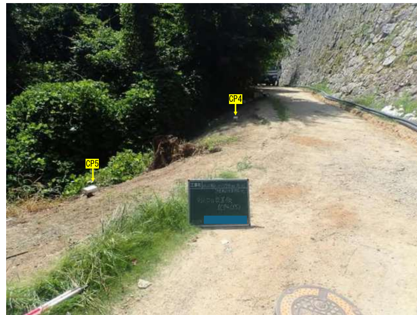
写真7 クリノポール CP4、CP5 設置状況全景（終点側から撮影）
