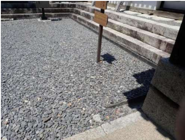
写真-1 仕切門内側の小広間の側溝水路 小広間に降った雨水は側溝水路で集められ、仕切門の暗渠水路を通じて天神櫓前広場方向へ流れる。
