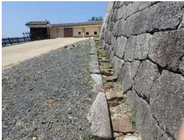
写真-11 一ノ門櫓南側スロープの側溝水路（写真-10 反対側より） 石垣沿いに側溝水路が設置されている。
