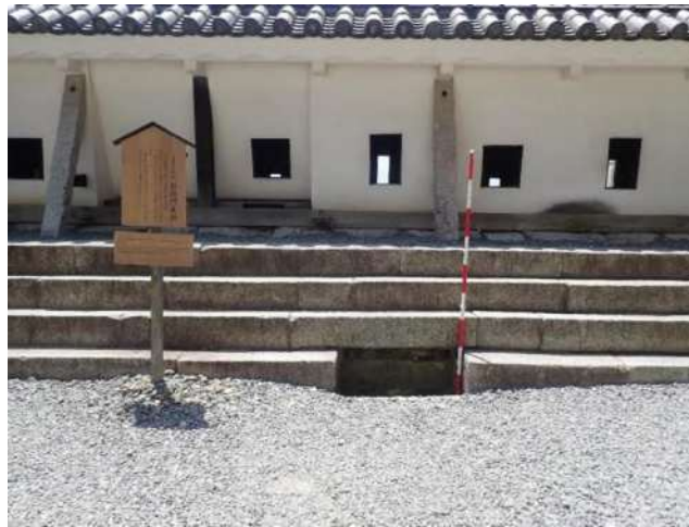
写真-8 天守閣南の小広場の集水樹 集水樹で集められた流水は塀下の暗渠を通して一ノ門前の広場へ流下する。
