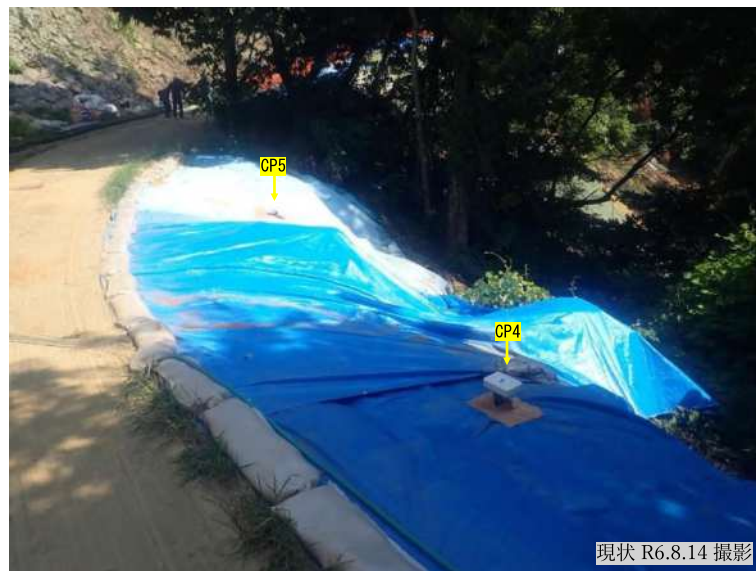
写真8 クリノポール CP4、CP5 設置状況全景（起点側から撮影）ブルーシート養生後
