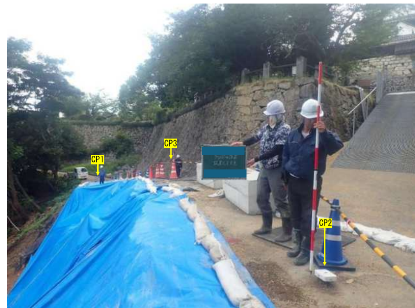
写真2 クリノボール CP1、CP2、CP3 設置状況全景（終点側から撮影）
