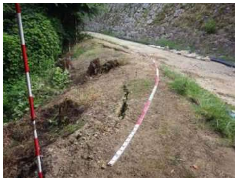
写真1 クラック全景。延長15m程度である。
