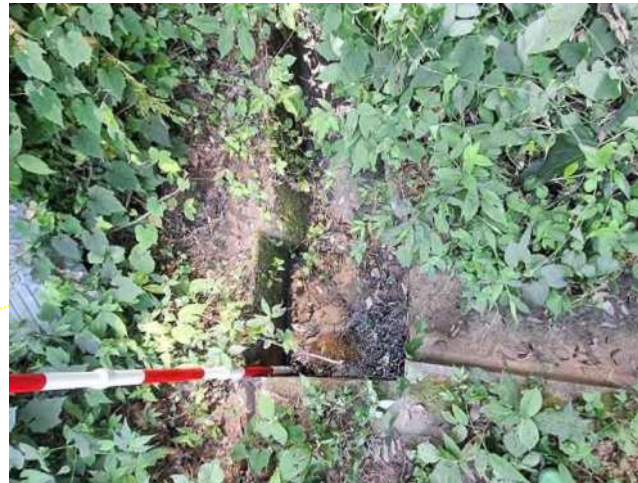
写真 3-22 水路工末端の集水樹 大きさ 0.6×0.6×0.5m 程度 樹内に溜り水があるが流水なし
