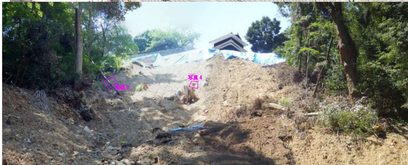
写真1 緊急車両用道路直下の斜面状況。斜面勾配 35~40°。ガリー状の侵食跡が発達する。表層から 1m 弱は不安定な状態と推定。
