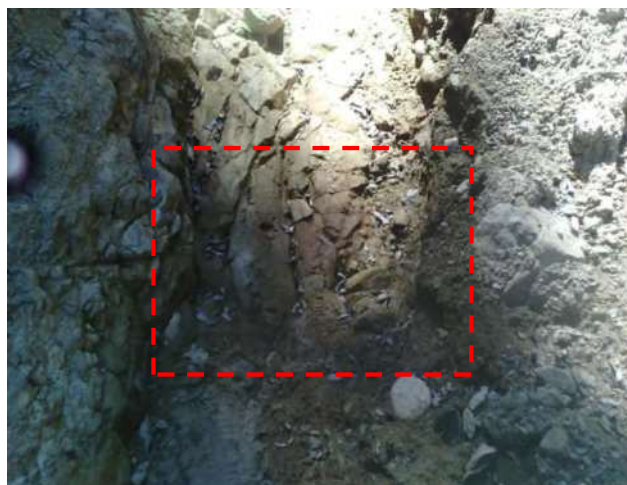
図 2-21 湧水箇所の状況 侵食により礫岩（写真の右側）と砂岩（中央部）が露出 砂岩部より湧水染み出し （赤破線で囲った範囲は熱赤外線サーモカメラで測定）
