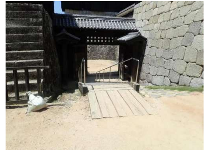
写真-9 二ノ門櫓前の階段と側溝水路 この辺りの表流水は側溝水路を通して西側へ流れる。
