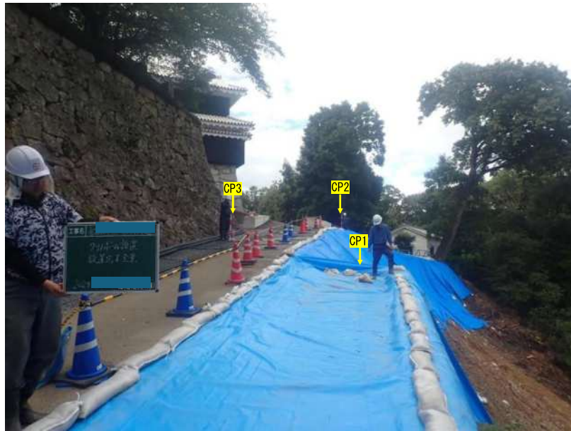
写真1 クリノボール CP1、CP2、CP3 設置状況全景（起点側から撮影）
