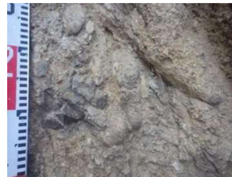
写真 1-1 土砂流出斜面の上流部（上部） ガリー侵食底面に認められる礫岩 花崗岩・泥岩の円礫含む。新鮮・硬質
