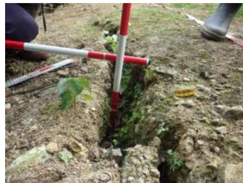
写真2 段差6cm・開きW15cm・深さD34cm。 クラック内に草が繁茂している。
