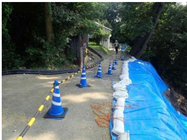
写真-13 緊急車両用道路の道路端の状況 この辺りが緊急車両用道路で最も高い。 表流水は道路に沿って北東方向へ流れ斜面下側へ流下するが、やせ尾根となっており背後の集水範囲は狭い。
