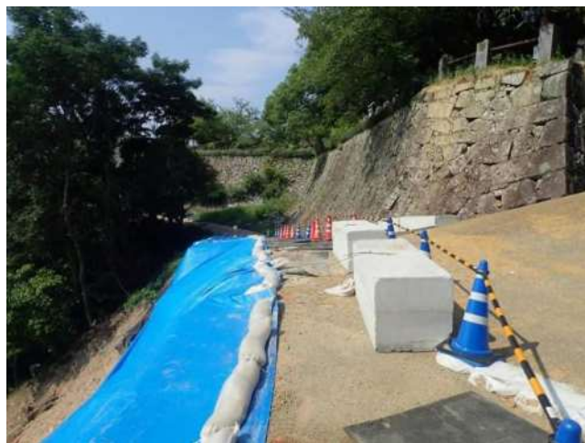
写真-14 緊急車両用道路の道路端の状況 この辺りが緊急車両用道路で最も高い。 表流水は道路に沿って南西方向へ流れ、斜面側へ流れる表流水は少ないと想定される。
