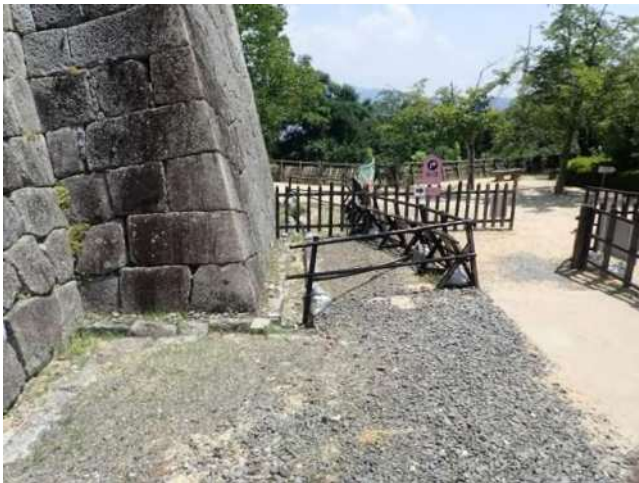
写真-10 一ノ門櫓南側スロープの側溝水路 石積み沿いに側溝水路が設置されている。 天守広場～天守閣南の小広場の雨水はこの側溝を流下すると考えられる。
