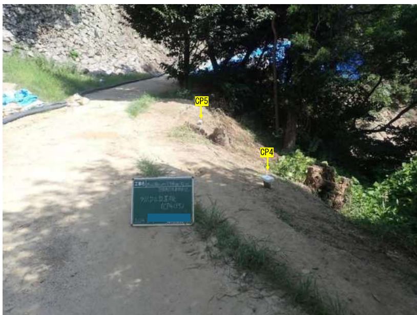
写真6 クリノポール CP4、CP5 設置状況全景（起点側から撮影）
