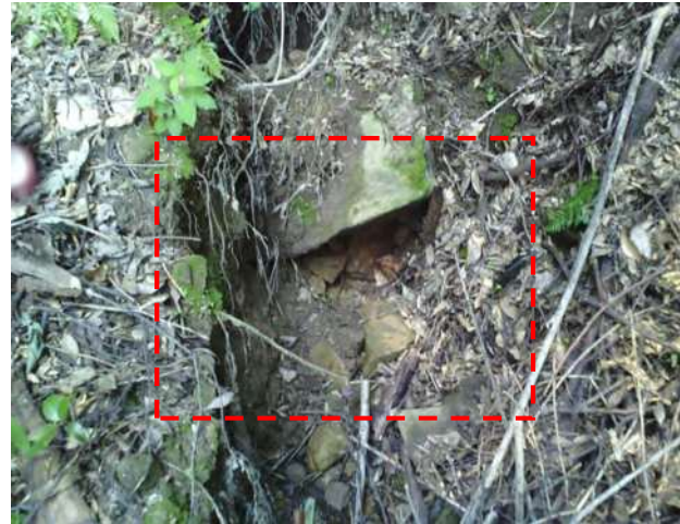
写真 3-8 湧水源頭部の状況 (拡大) 湧水染み出しが認められる (赤破線で囲った範囲は熱赤外線サーモカメラで測定)
