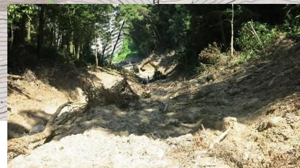
写真2 上流部(下部)の堆積物。 谷全体に堆積物が分布する。倒木が認められる。
