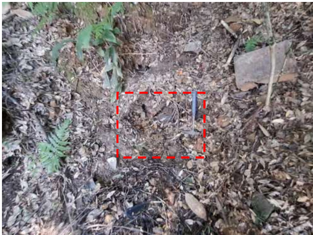
写真 3-10 湧水源頭部の斜面上方 2m 程度 湧水染み出しが認められる (赤破線で囲った範囲は熱赤外線サーモカメラで測定)
