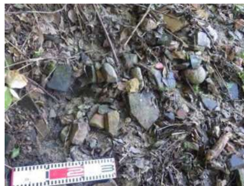
写真 2 B 箇所の斜面内 瓦、陶器、花崗岩礫、ビニールなどが認められる。
