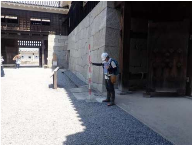
写真-7 天守広場内の側溝水路および集水樹の状況 天守広場内の降りは側溝水路で集められ、筋鉄門の暗渠水路を通して天守閣南の小広場方向へ流れる。
