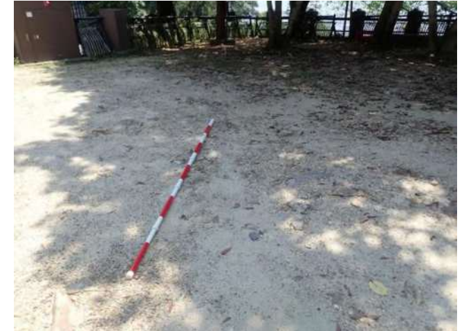
写真-6 良門南側の広場に認められる地表の流水跡 表流水は東方向へ流れ、良門南石垣を流下する。
