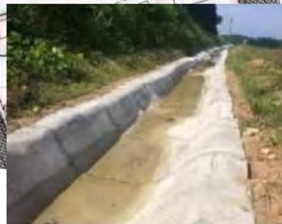
図 1-3 コンクリートキャンバスの施工事例
