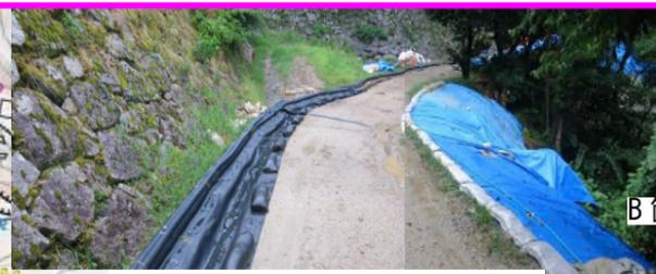
図 1-4 応急側溝の施工状況
