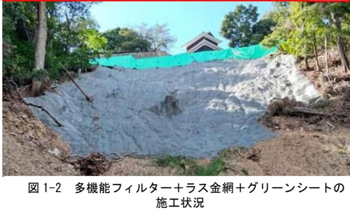
図 1-2 多機能フィルター+ラス金網+グリーンシートの施工状況
