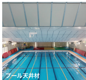
プール天井材
