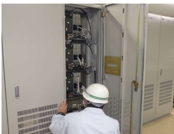
【電気通信施設の点検】
