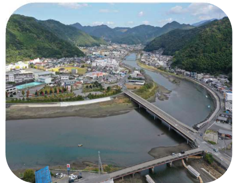
(二) 岩松川 津島大橋付近
