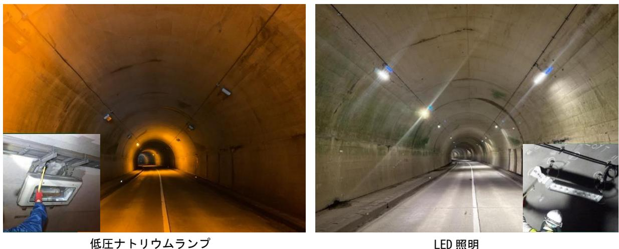
図 9 LED 化後のトンネル照明の比較（下中合トンネル）
