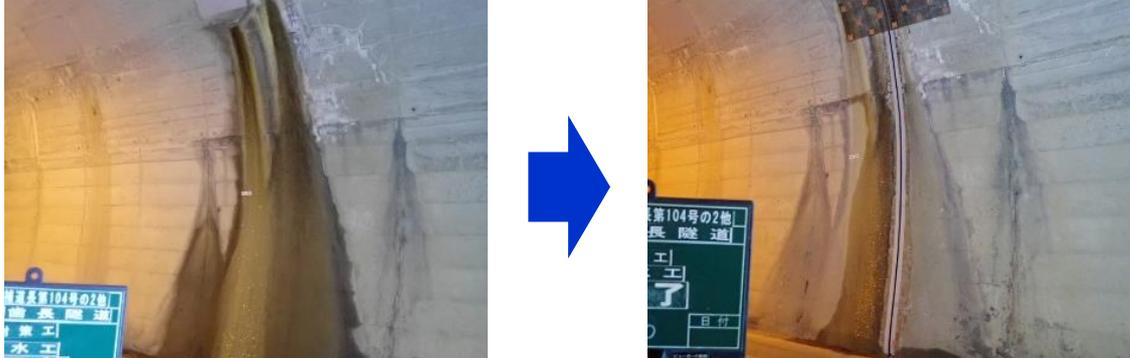
◆ 裏込め注工（国）197号 川之浜第1トンネル 延長 192.0m 1986 年建設
