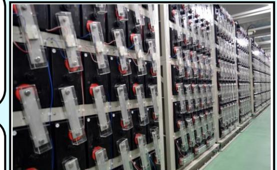
太陽光パネルで発電した電力を大容量の蓄電池（3,456kWh）に蓄えています。非常用電源としても活用します。
