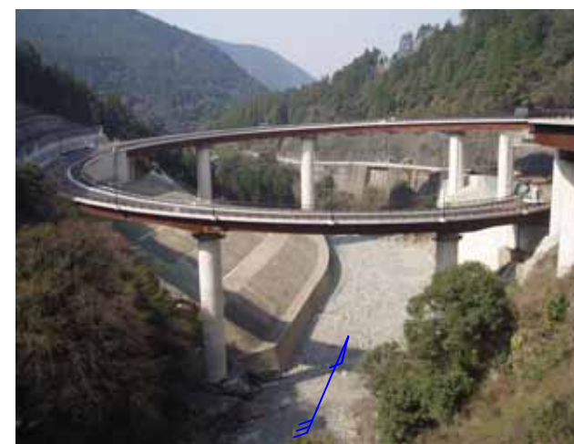
手前側：第一青龍橋 奥側：第二青龍橋
