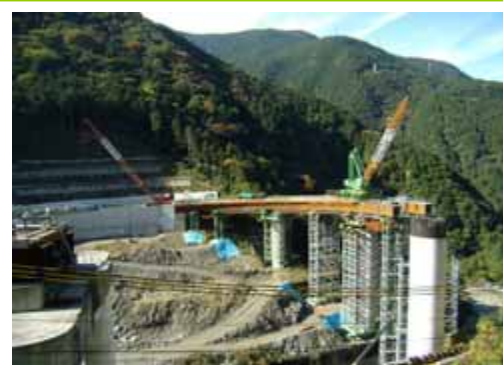
B 工区架設状況(トラバークレーン架設)
