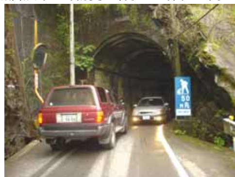
幅員が狭く急カーブのトンネルが連続し、離合・大型車の通行が困難な現道
