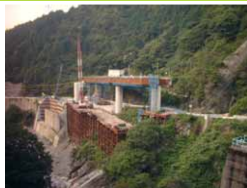
C 工区架設状況(張り出し架設)
