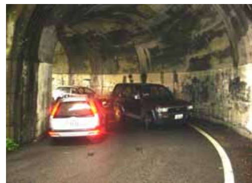
幅員が狭く急カーブのトンネルが連続し、離合・大型車の通行が困難な現道
