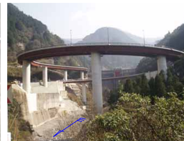
手前側：第二青龍橋 奥側：第一青龍橋
