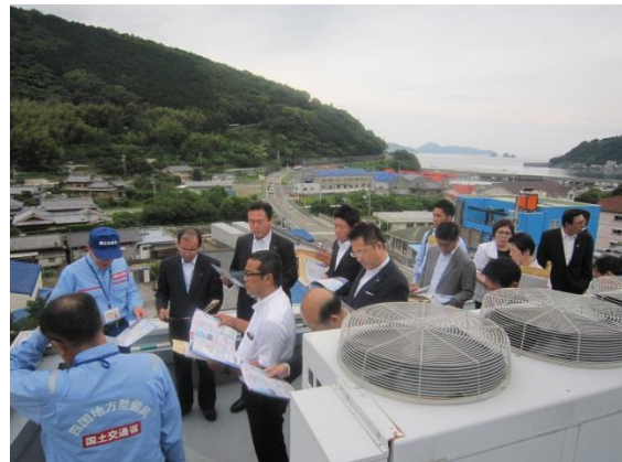
津島道路(内海 IC(仮称))建設現場 （南宇和郡愛南町）
