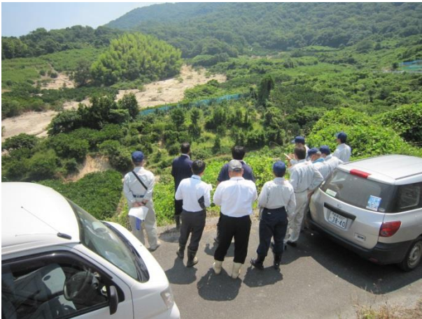
樹園地流出現場 (今治市上浦町)
