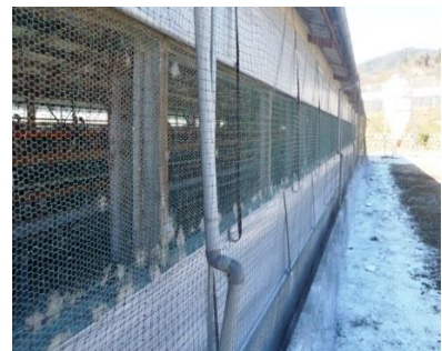
写真3 消石灰散布と防鳥ネットによる対策
