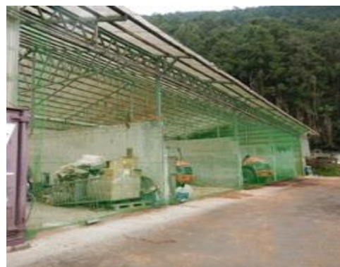
写真1 堆肥舎に設置した防鳥ネット 野鳥や野生動物の住処と ならないようにする
