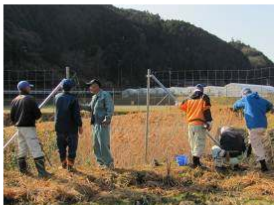
フェンス設置技術現地講習会
