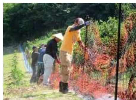
ネット張りの様子
