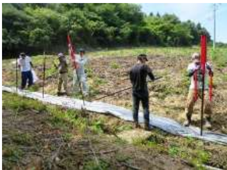
支柱立ての様子
