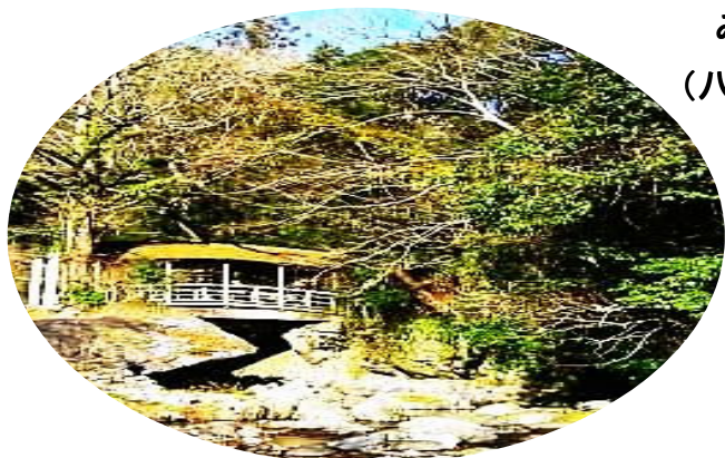
御幸の橋 (大洲市河辺町北平)
