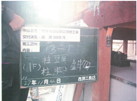
構造用金物による補強
