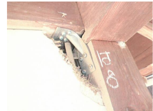
構造用金物による補強
