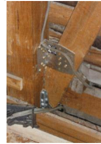
2階洋室金物取付1
