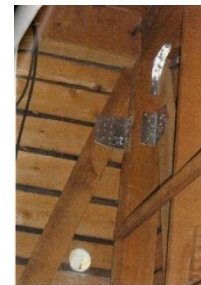
2階洋室金物取付2
