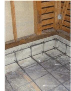
1階洋室配筋基礎
