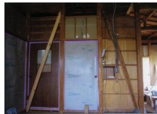
(筋かい工事中)
