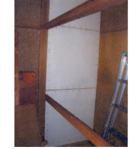
押入れ内の壁を構造用合板で補強 (補強後)
