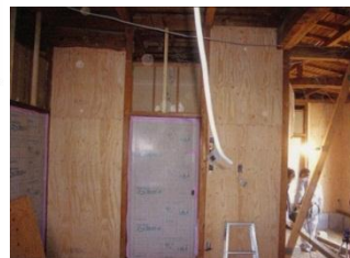
(構造用合板施工後)
