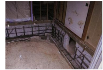
(台所基礎配筋)
