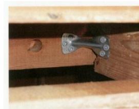
柱頭金物による補強
