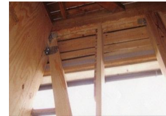
(筋かい金物による補強)
