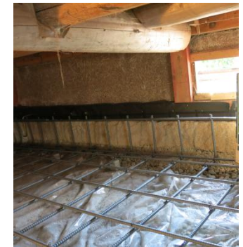
基礎の増打ち補強
