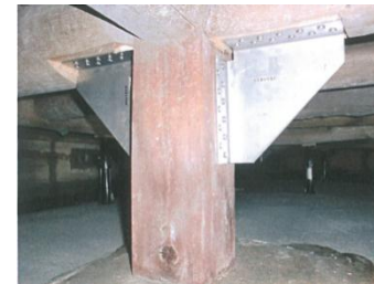
仕口ダンパーによる補強
