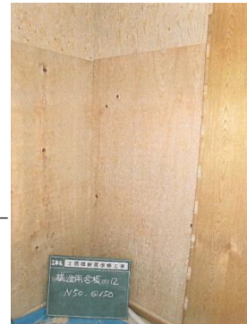
構造用合板による補強
