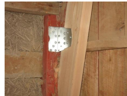
筋かい金物による補強
