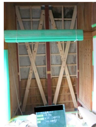
押入れ内の壁を筋交いで補強
