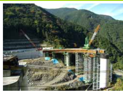
B 工区架設状況(トラベラークレーン架設)
