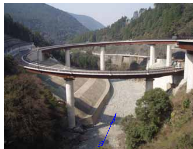
手前側：第一青龍橋 奥側：第二青龍橋
