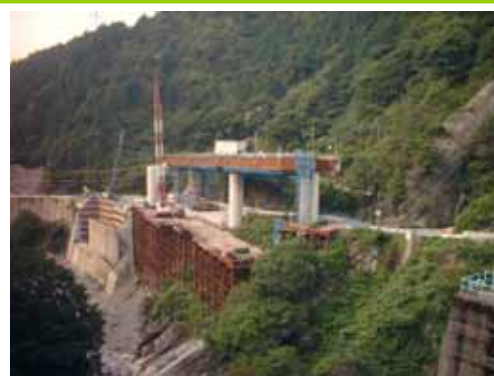
C 工区架設状況(張り出し架設)
