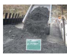
攪拌混合した内部材を堰堤内部に運搬
