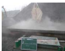
混合枘に現地発生土とセメントを投入
