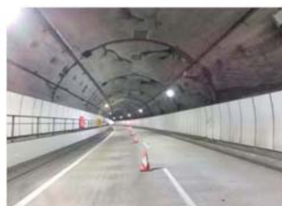
取替後：LEDランプ
