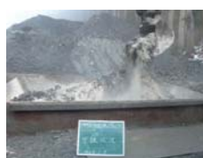
現地発生土とセメントを攪拌混合
