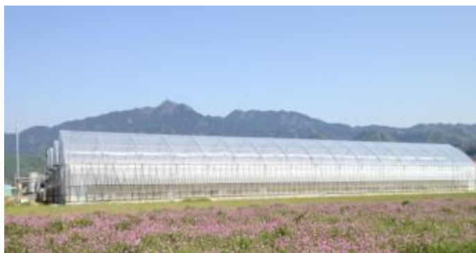
30a（4連棟）のトマトハウス全景
