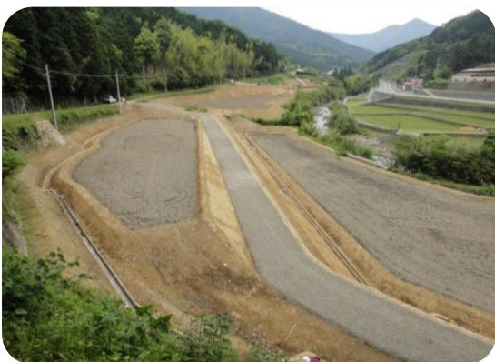
棚田のほ場整備
