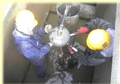
パイプラインのバルブ更新
