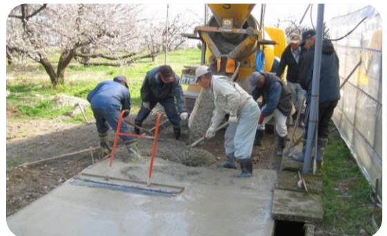
農道の舗装 (西条市)
