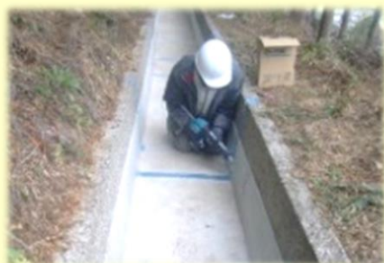
開水路の目地補修
