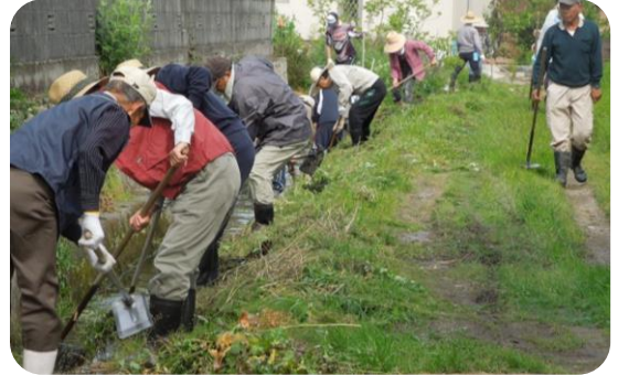
水路の泥上げ (松前町)
