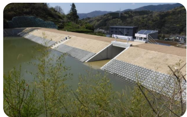
堤体を改修したため池 (東温市)
