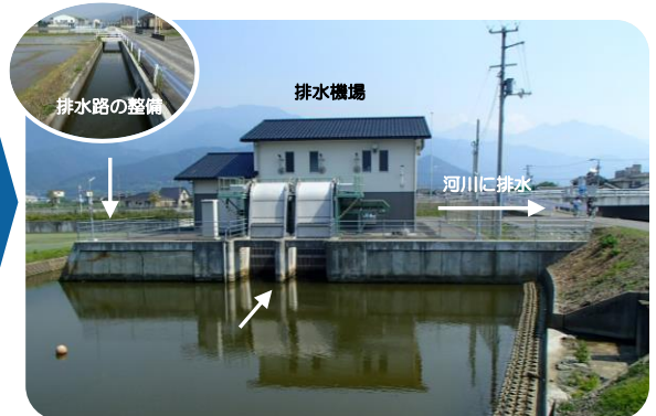
排水機場の整備 (西条市：玉津・下島山地区)
