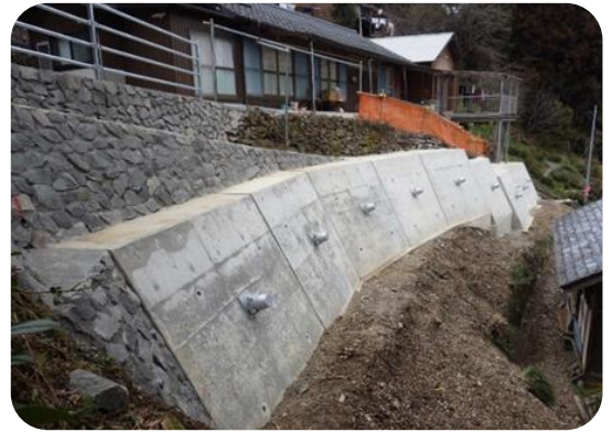
アンカーによる抑止 (久万高原町：松木地区)
