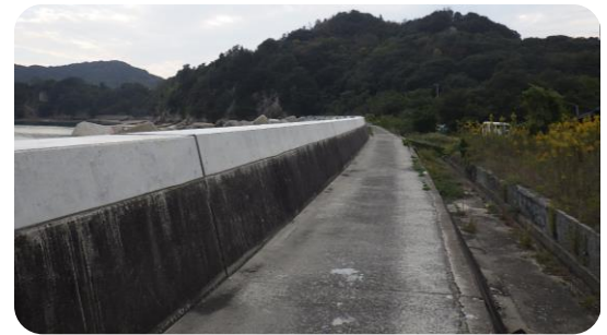
堤防の嵩上げ (上島町：佐島東地区)
