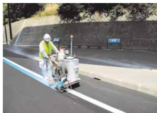
媛マルライン施工
