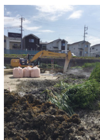
沼地の地盤改良固化
