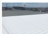
倉庫屋根 (群馬県)
