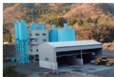
県内の火力発電所で発生した石炭灰(フライアッシュ)と、セメント、生石灰を専用プラントに投入する。
