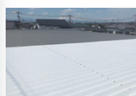
倉庫屋根 (群馬県)
