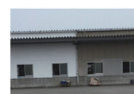
工場屋根と壁面 (愛媛県)
