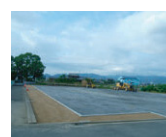
駐車場の造成工事
