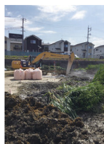
沼地の地盤改良固化
