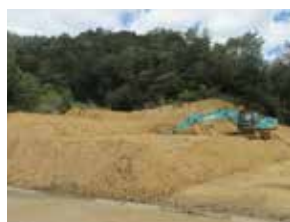
①鋼土（コア土）ため池工事
