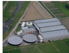
バイオガス設備
