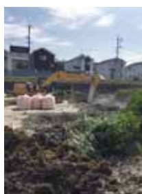
沼地の地盤改良固化
