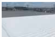
倉庫屋根（群馬県）
