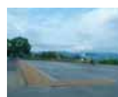
駐車場の造成工事
