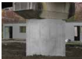
耐震補強工事
